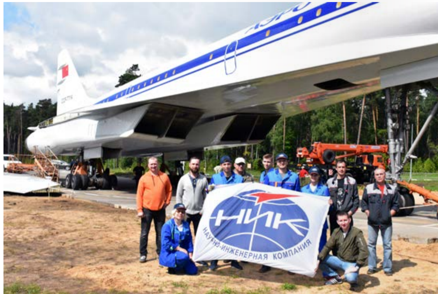
Установка специалистами ООО «НИК» и волонтерами передней опоры памятника Ту-144
