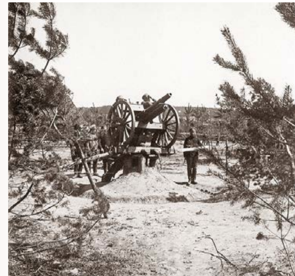
Полевое орудие на противосамолетной установке
