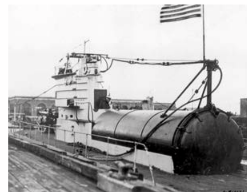
Рис.20. Герметичный ангар для биплана Caspar U1 на корме субмарины S-1, США, 1923 г.
