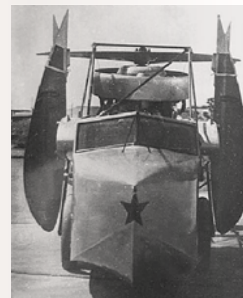
Рис.32. Оригинальный самолёт-разведчик СПЛ-1 конструкции Четверикова, СССР, 1934 г.
