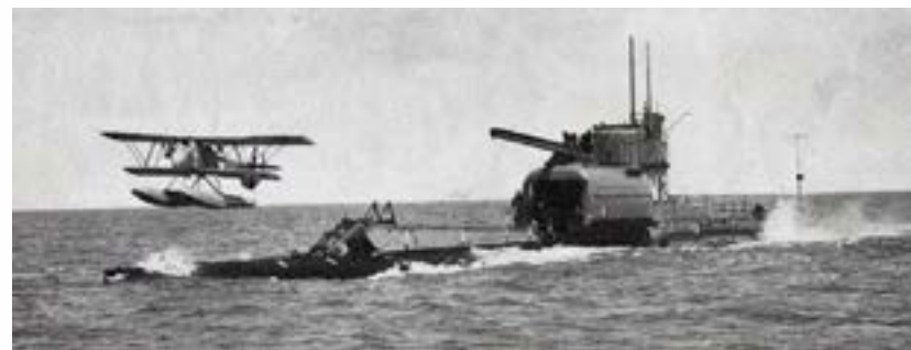
Рис.10. Катапультный старт Parnall Peto с субмарины M2, Британия, 1928 г.
