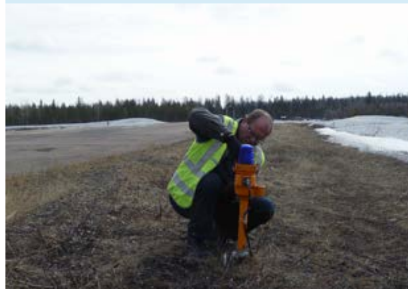
Осмотр рулежных огней. Аэропорт Алдан
