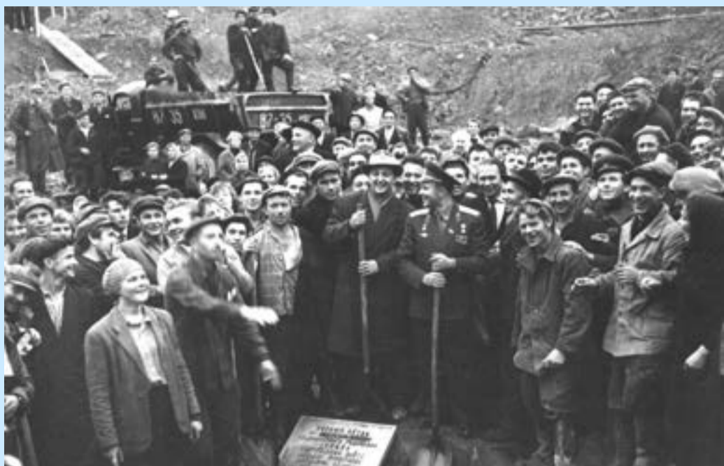
Гагарин с гидростроителями Красноярской ГЭС, 25 сентября 1963 г.
